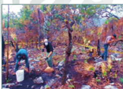
Rastrilleo y retiro de sedimento para pasar a cribado.
